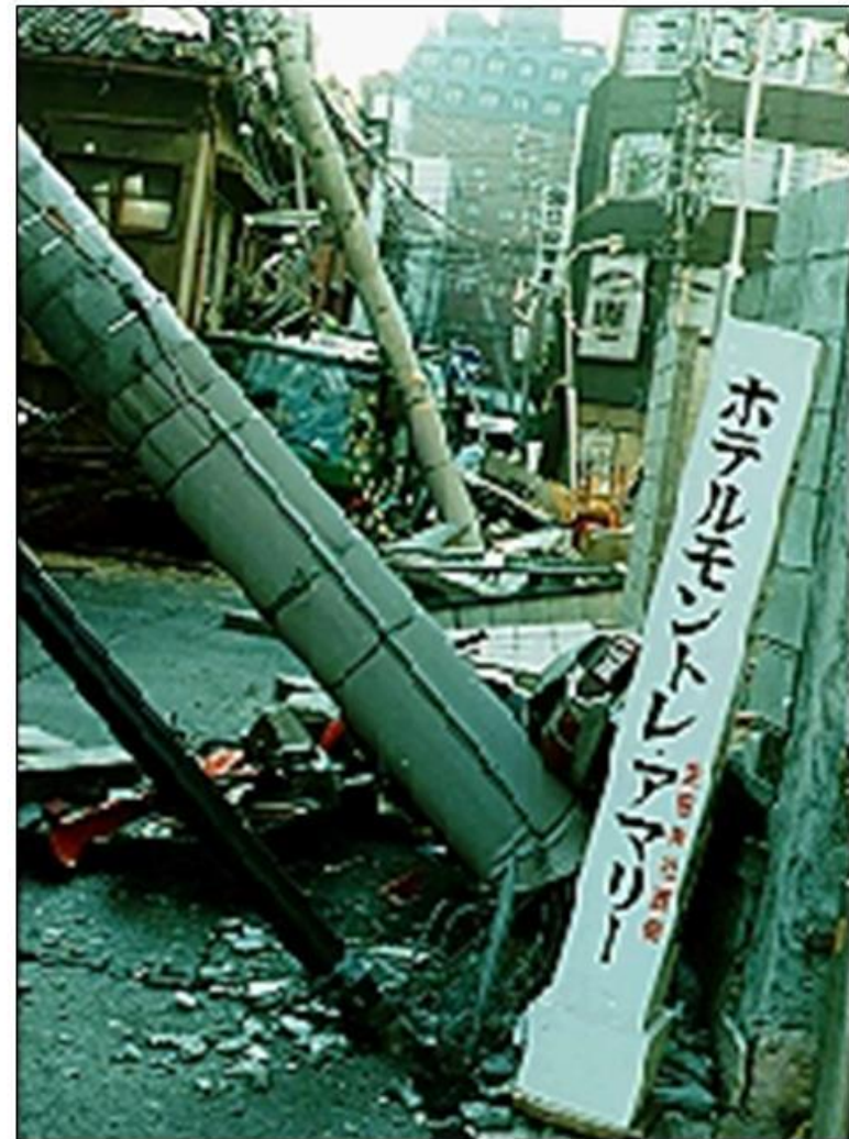
配電線に被害 (生田神社西側)
