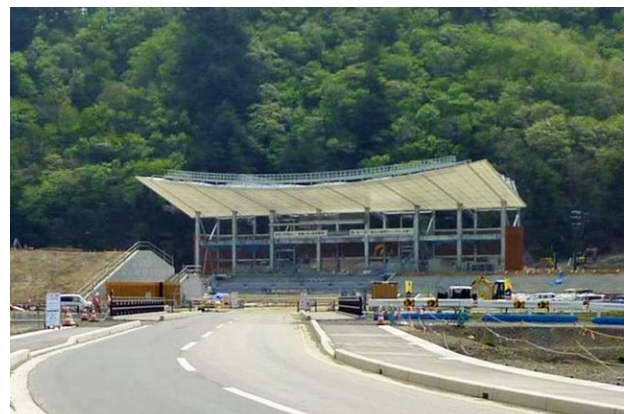
鵜住居小跡地にラグビー場建設 2018年4月
