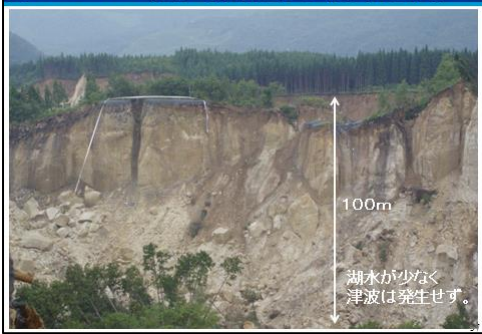
図3.3.19 岩手・宮城内陸地震・荒砥沢ダム
