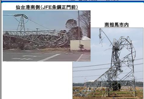
図3. 4. 26 送電設備の被害
