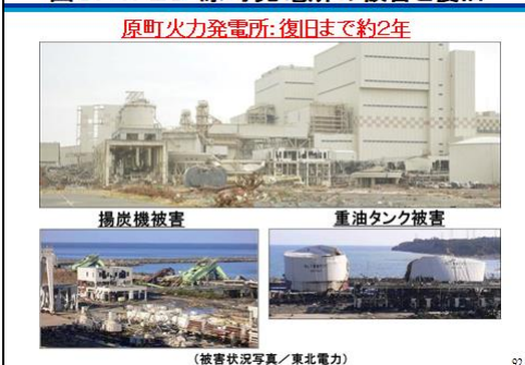
図3. 4. 23 原町発電所の被害と復旧
